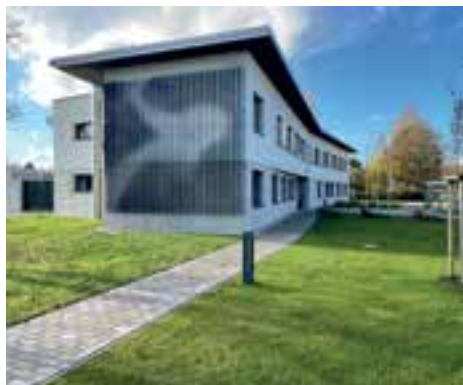
Auf der Ostseite ziert ein Reliefbild die Polizeistation, deren Sockelgeschoss aus Liapor-Leichtbeton besteht. Foto: Sabine Straub
